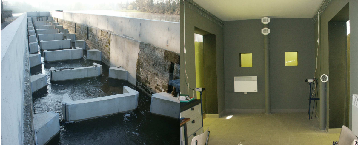
Illustration 3 : Passe à bassins à doubles fentes verticales et salle de vidéo comptage de Descartes.
