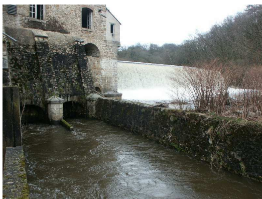
Illustration 4 : A gauche, le barrage de La Roche-Etrangleloup et son usine, à droite : détail de la passe à poisson.
