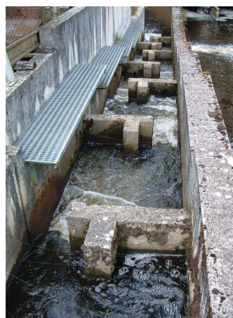
Illustration 4 : A gauche, le barrage de La Roche-Etrangleloup et son usine, à droite : détail de la passe à poisson.
