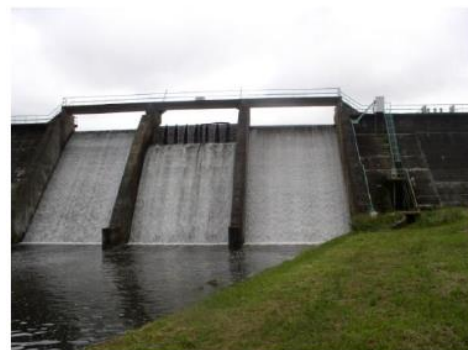
Barrage de Sorin, Source FVPPMA
