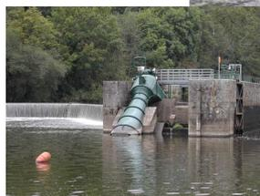
Figure 8 : Turbine à siphon sur l'axe Mayenne
