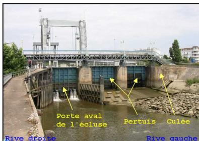
Figure 2 : Le barrage-écluse de Saint Félix (photo : J. Viillard).
