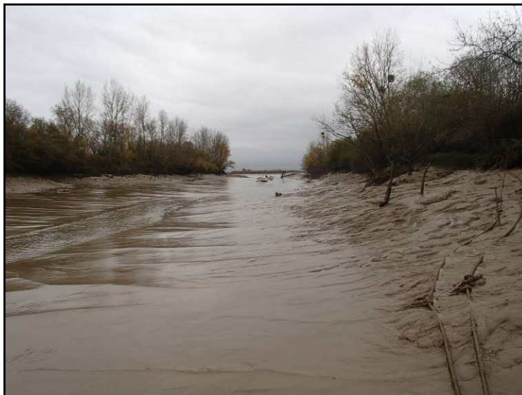
Figure 80 : Vue aval du vannage de Buzay à marée basse (FISH PASS)
