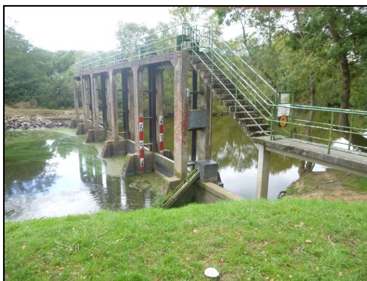
Figure 13 : Vue de coté de l'ouvrage de Bouaye (FISH PASS)
