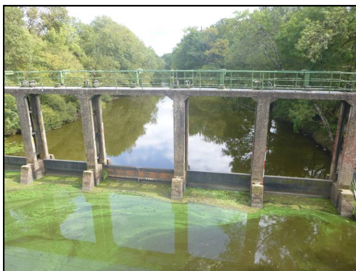
Figure 14 : Vue aval de l'ouvrage de Bouaye (FISH PASS)
