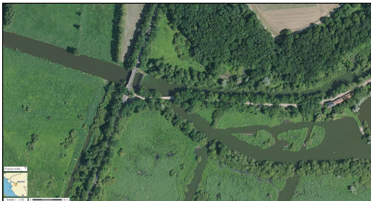
Figure 15 : Vue aérienne du vannage de Bouaye (IGN)
